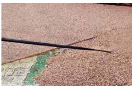
4. Extiende el material sobre la superficie.
