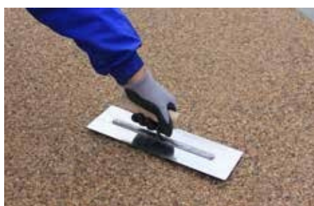
5. Compactar el material con una llana.
